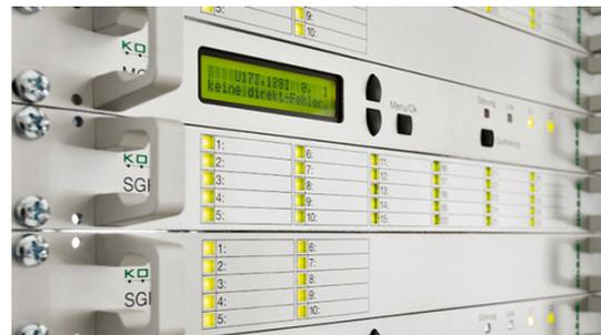
Abbildung 3: Nutzerschnittstelle einer Gebäudeleittechnik<sup>7</sup>
